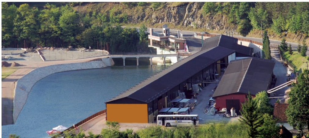
Комплекс производственных цехов предприятия Domis находится в Миоковцах возле Чачка
